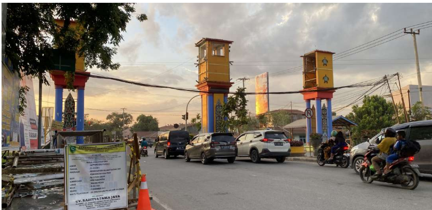
Foto: Perbaikan gapura di simpang 4 Km 5 mulai dilakukan.
